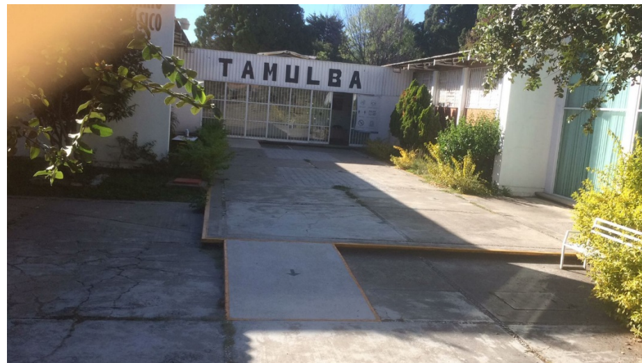
Rampas de acceso para alumnos con sillas de ruedas (TAMULBA)
